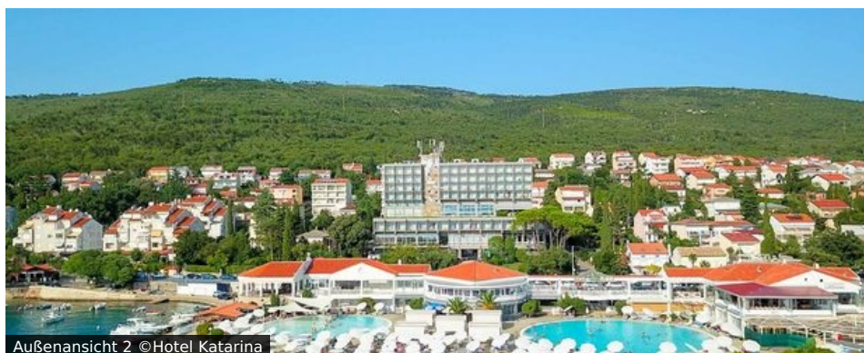
Außenansicht 2 ©Hotel Katarina
