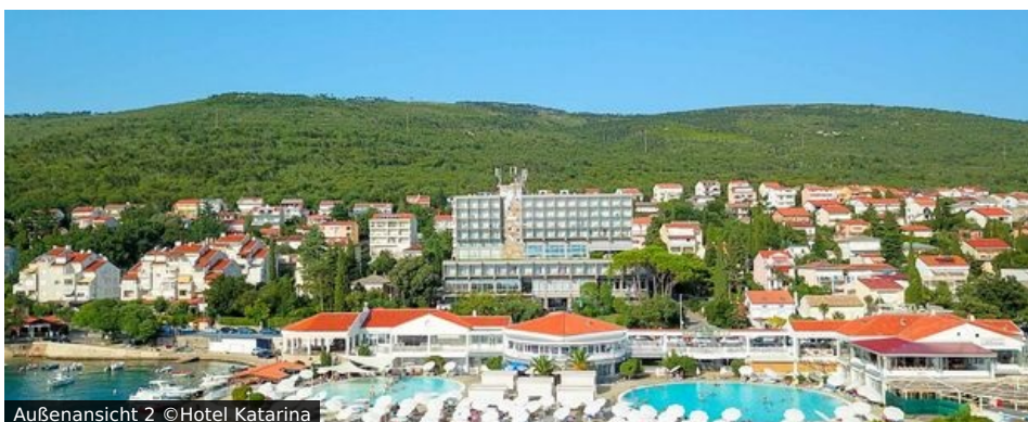
Außenansicht 2 ©Hotel Katarina
