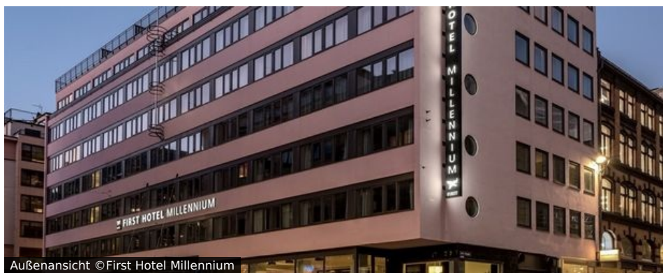
Außenansicht ©First Hotel Millennium
